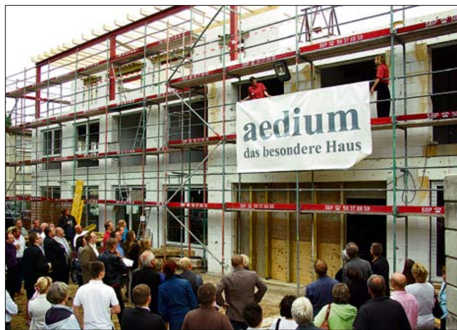
Zahlreiche Besucher kamen, um das „Aedium“ bereits im Rohbau zu begutachten
