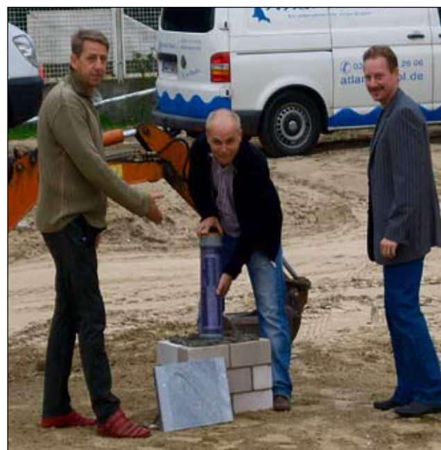
Die Poolbauer beim ersten Spatenstich in Hennigsdorf
